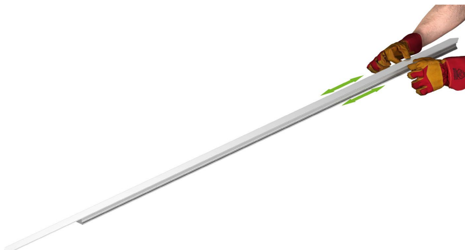
Rys. 5.28: Zaciskanie taśmy osłonowej na długości ok. 3 cm
