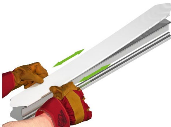
Rys. 5.27: Montowanie taśmy osłonowej
