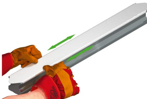
Rys. 4.8: Montaż początku taśmy
